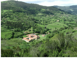
Valdedios subiendo la Campa
