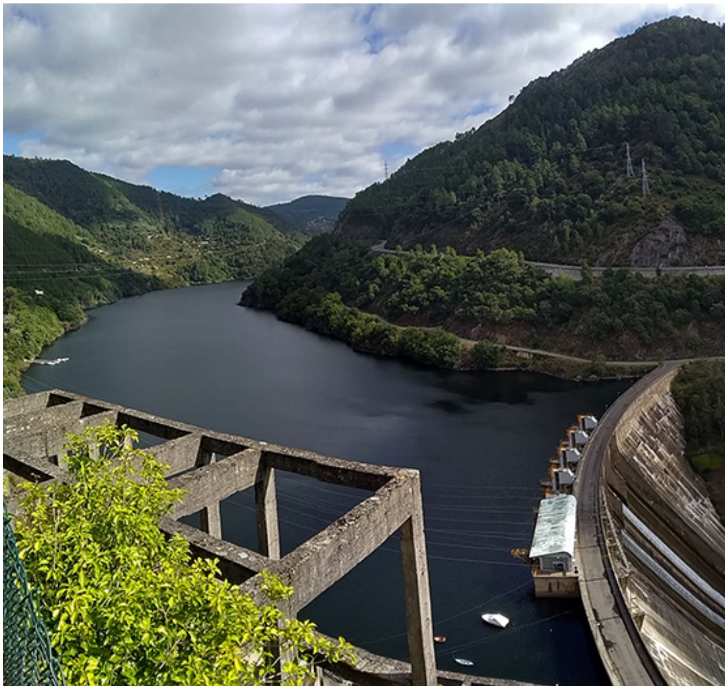
Presa de la central hidráulica de Belesar
