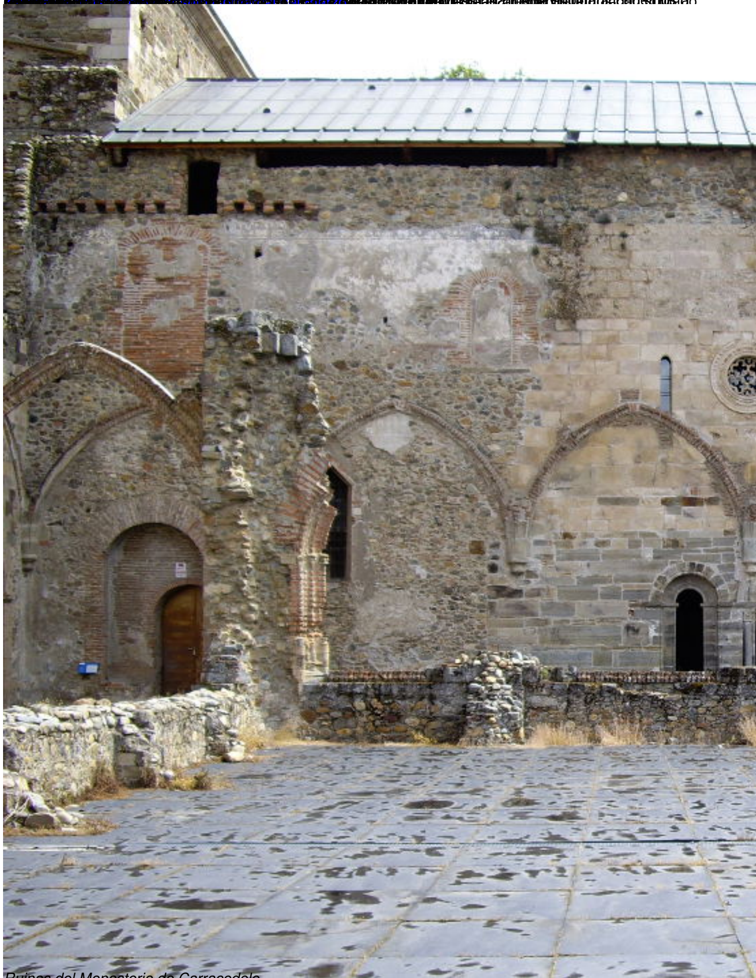
Ruinas del Monasterio de Carracedelo
