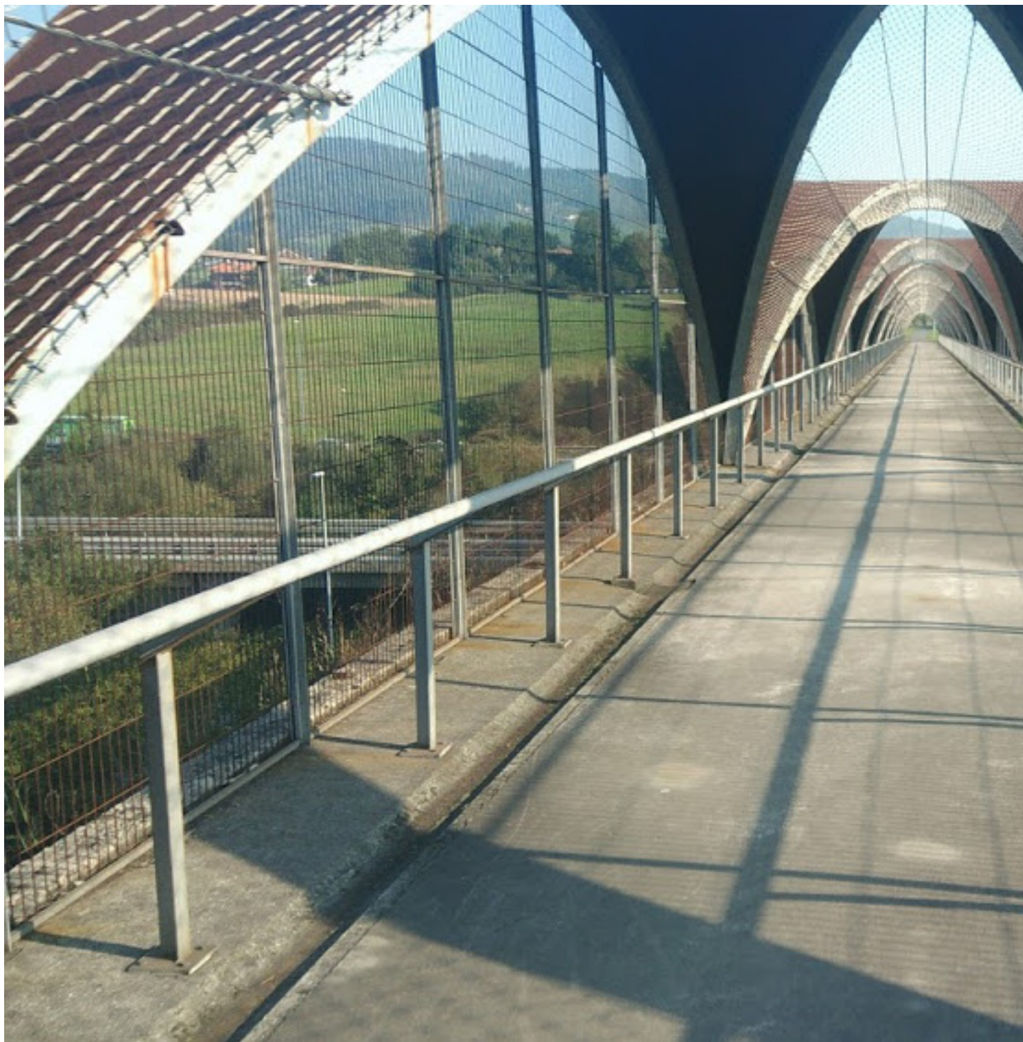
Puente de Serín
