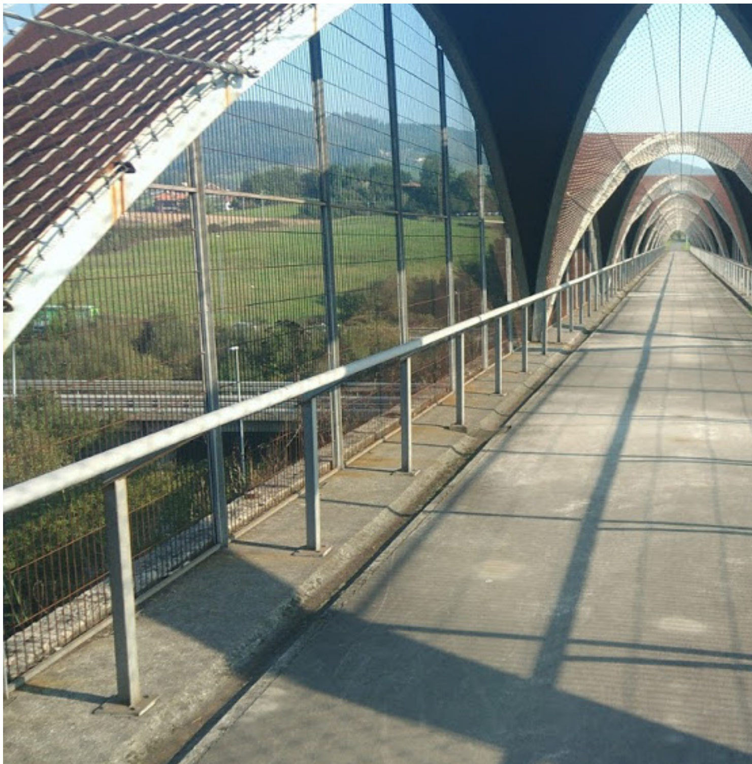
Puente de Serín
