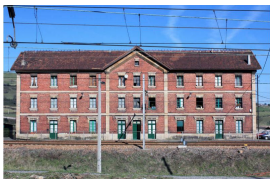
Antigua residencia de empleados ferroviarios
