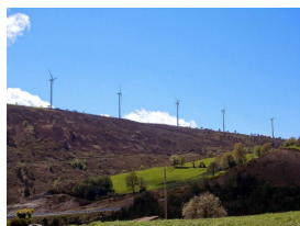
Parque eólico de La Sierra de Bodenaya, Salas
