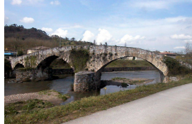
El puente Romanón o Puente Viejo, Lugones
