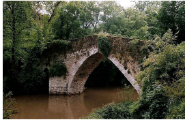
Puente del bajomedievo en Brañes
