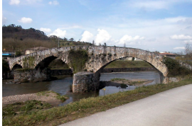
El puente Romanón o Puente Viejo, Lugones
