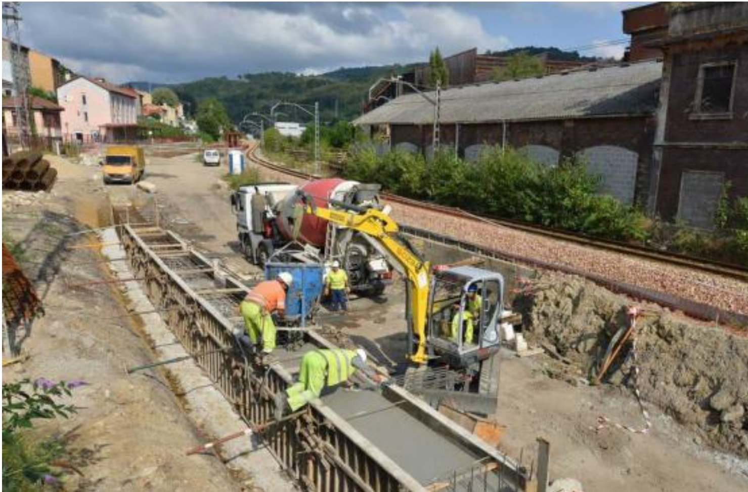
Obras en la línea Gijón-Laviana a la altura de Tuilla
