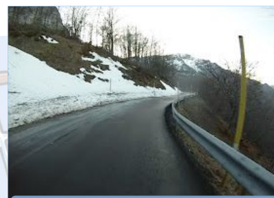
Descenso por el puerto Ventana
